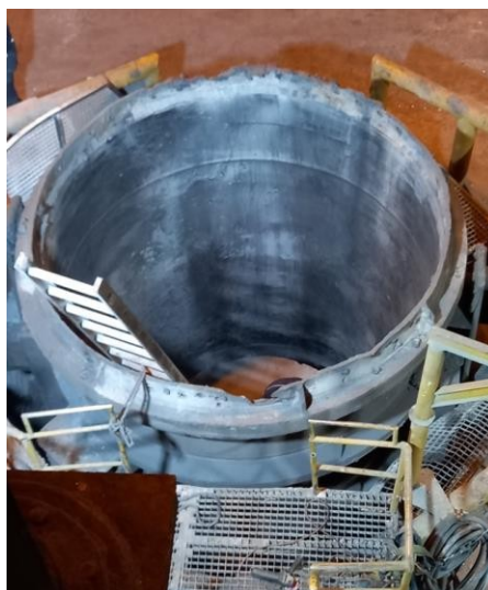
Figura 14. Revestimiento refractario de seguridad interno de la cuchara reconstruido a nuevo.
