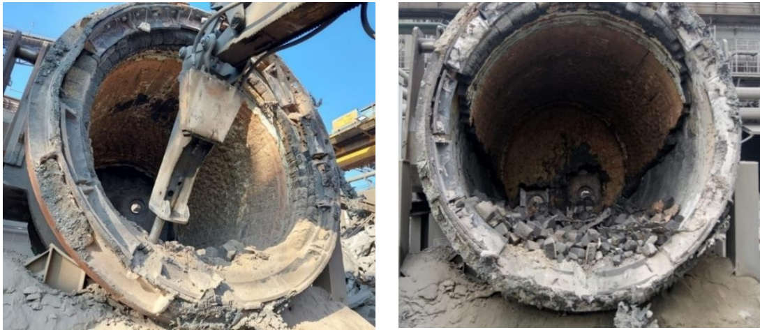
Figura 11. Demolición del revestimiento refractario de una cuchara.
