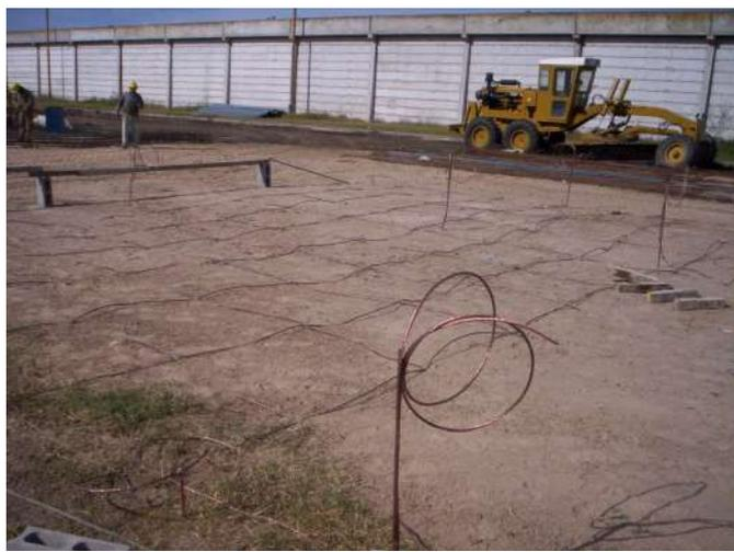
El Sistema de Puesta a Tierra de la estructura se realizó por medio de elementos dispersores (jabalinas) y una cuadrícula formada por cables de cobre desnudos de  $\varnothing 50\text{mm}$  vinculados por medio de soldaduras del tipo cuproaluminotérmicas. A esta forma constructiva se la denomina Malla de Puesta a Tierra. (Figura 11)
