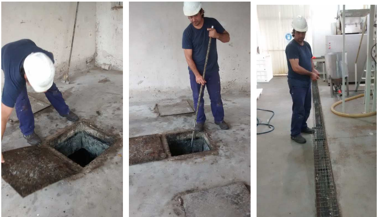
Figura XII. Operario del sistema de tratamiento de efluentes
