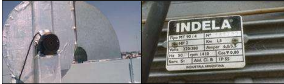
Figura 5: Imagen del ventilador centrífugo actual y datos técnicos correspondientes a su motor.
