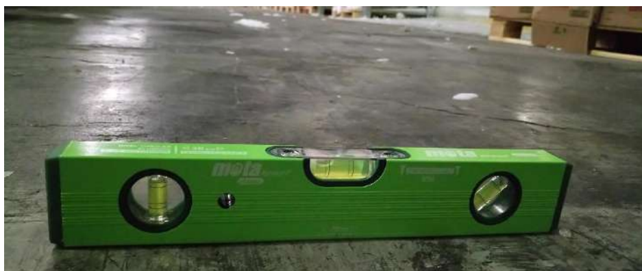
Figura 31- Zona con desnivel (I)
