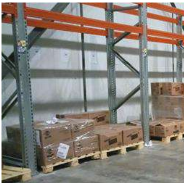
Figura 33- Altura de pallet de toma de cajas a 30 cm del piso
