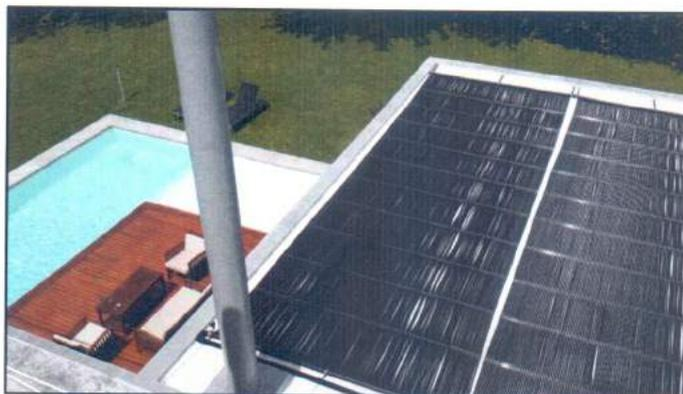
Figura 14: Sistema de climatización solar mediante colectores de polipropilenos.
