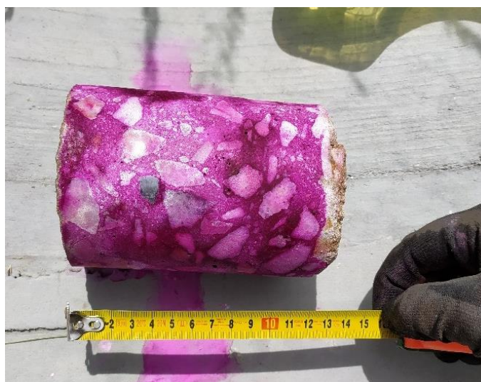
Figura 20. Espesor de recubrimiento.
