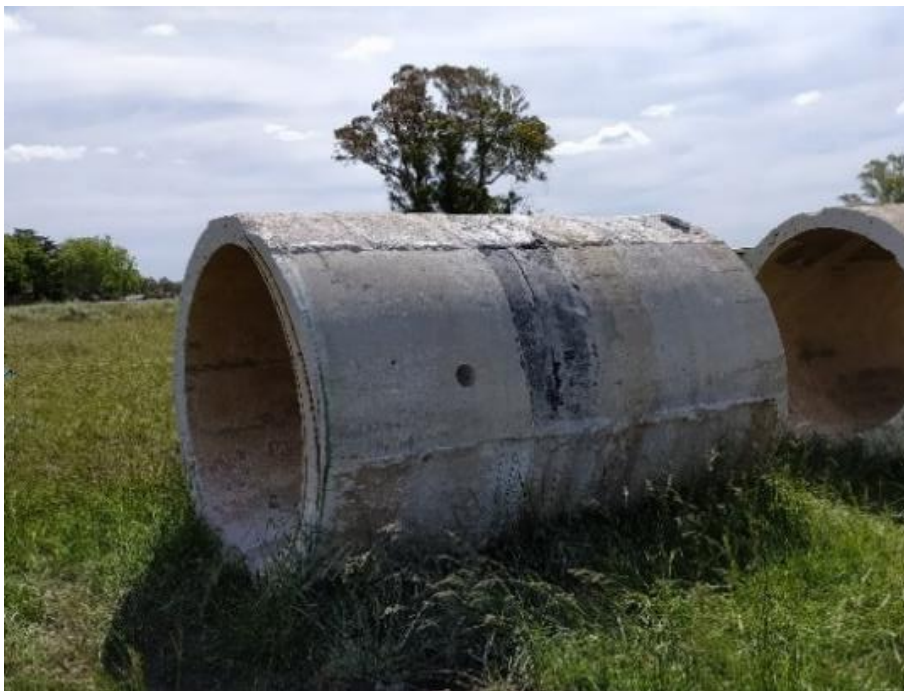
Figura 11. Vista general de la cañería analizada.
