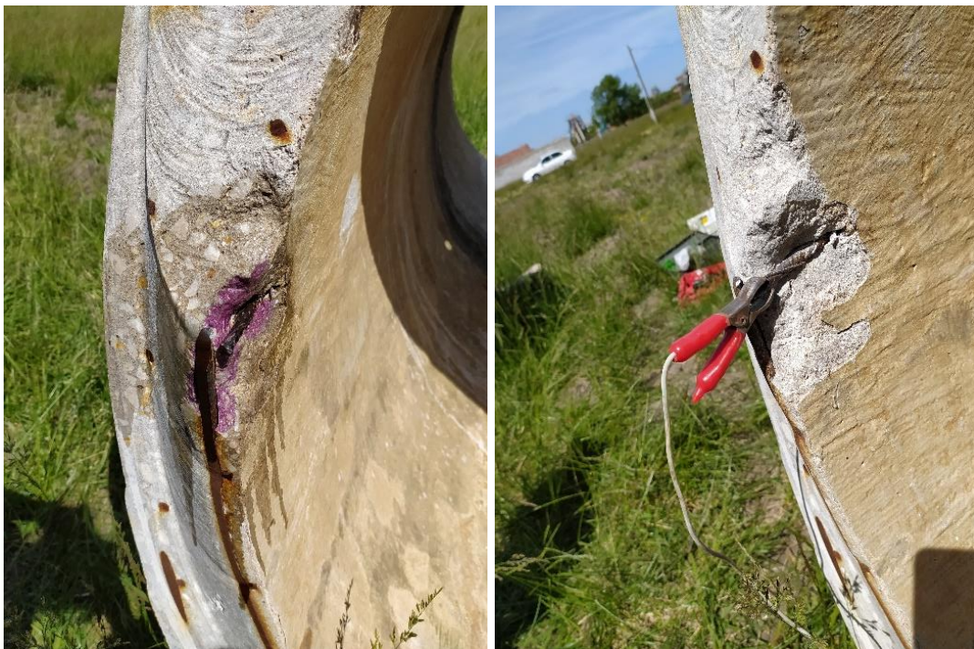
Figura 15. Preparación de superficie y conexión eléctrica con refuerzo en hora 9 de la cañería.
