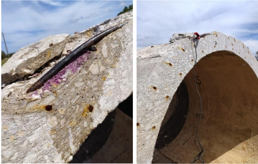
Figura 14. Preparación de superficie y conexión eléctrica con refuerzo en hora 12 de la cañería.
