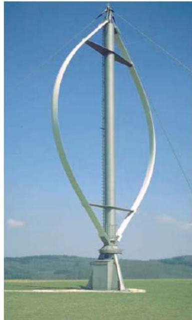
Figura 3.4: Esquema general de un aerogenerador tipo Darrieus 5 .
