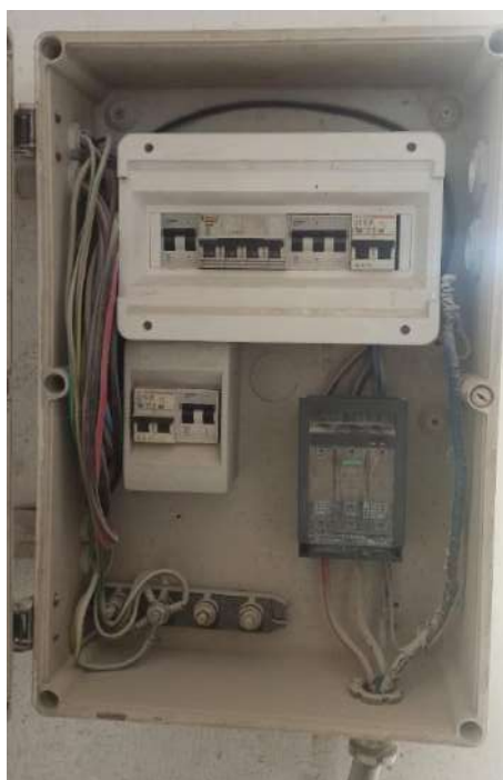
Figura 3.2.3.28 CIE: Tablero del compresor de la cabina de pintura y alimentación del sector C.
