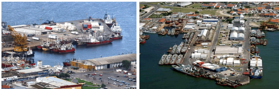
Figura 16: Terminal N° 2. Espigón N° 2
