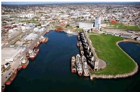
Figura 17: Terminal N° 3. Espigón N° 3
