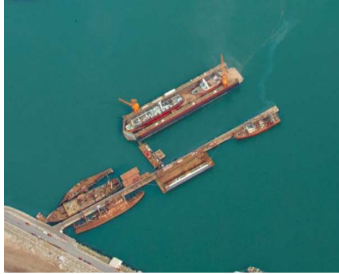
Figura 18: Terminal N° 4. Espigón N° 7
