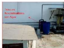
Figura 24: Tanques neutralizadores
