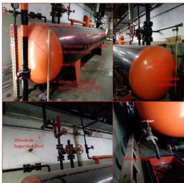
Figura 13: Recibidor de Amoníaco y sus características
