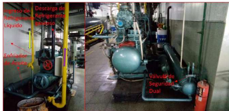
Figura 20: Enfriador de Aceite de Compresor Shantai N°2 y sus características
