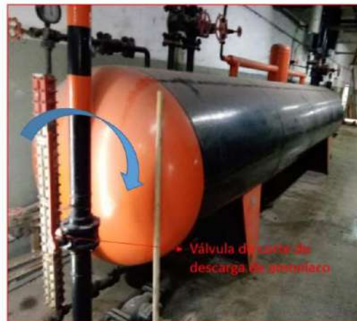
Figura 25: Válvula de corte de Recibidor de Amoníaco
