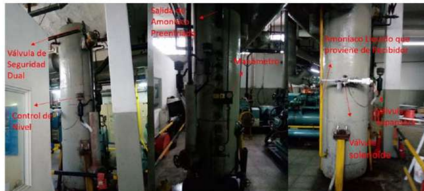
Figura 14: Separador de Intermedia y sus características
