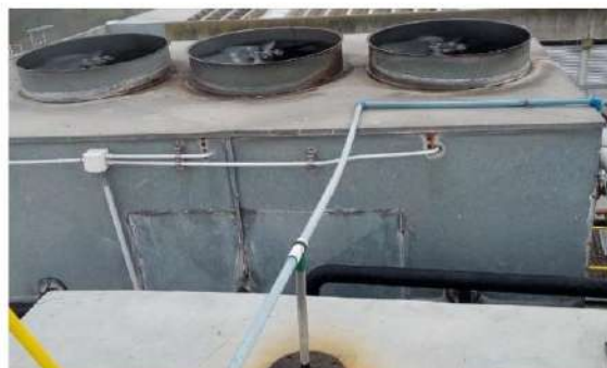
Figura 11: Condensador Evaporativo
