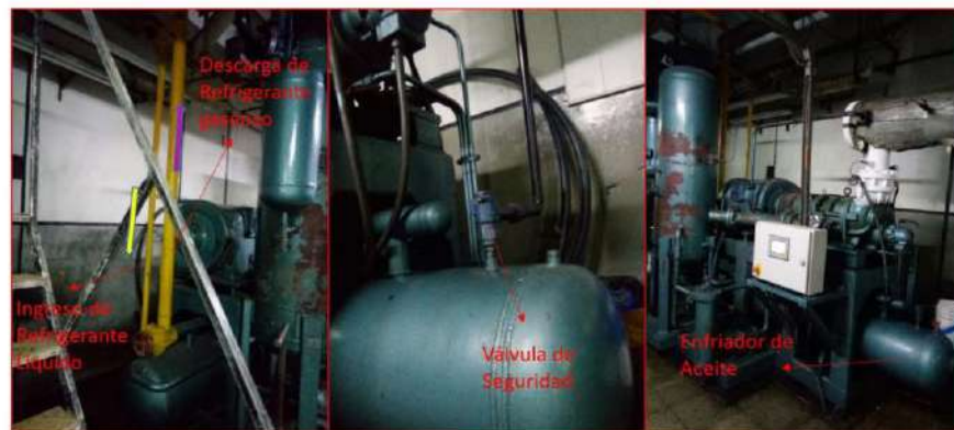
Figura 18: Enfriador de Aceite de Compresor Mycom N°1 y sus características
