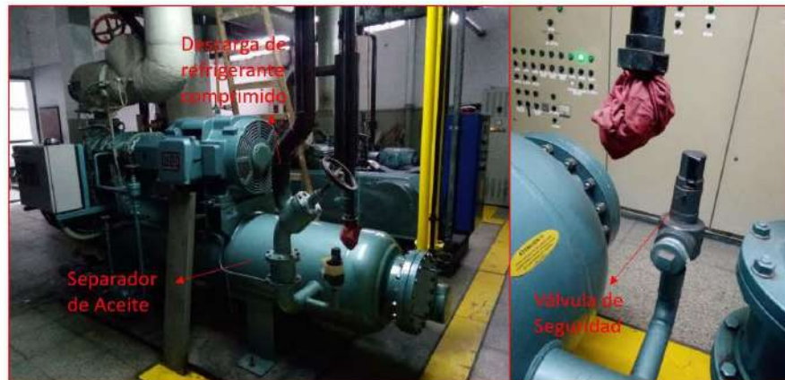
Figura 21: Separador de Aceite de Compresor Mycom N°3
