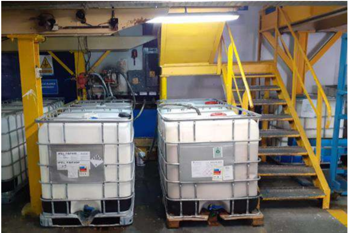
Ilustración 7. Situación actual de zona de reabastecimiento de aditivos.
