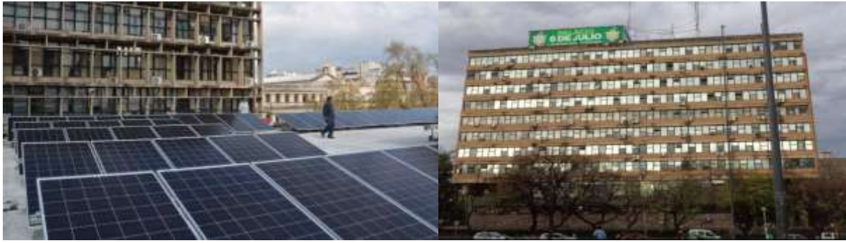
Figura 8: Instalación fotovoltaica en el Palacio 6 de Julio
