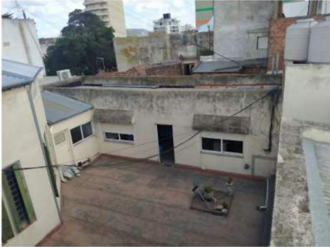
Figura 18: Zona II de la terraza del Palacio Municipal de Balcarce Fuente: Palacio Municipal de Balcarce, 2021
