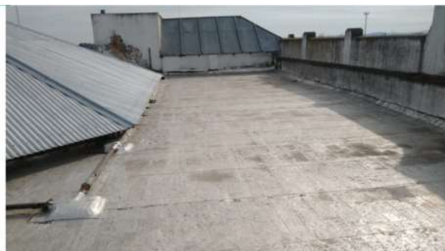
Figura 20: Zona III-2 de la terraza del Palacio Municipal de Balcarce Fuente: Palacio Municipal de Balcarce, 2021
