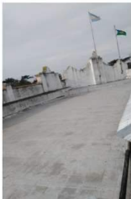
Figura 19: Zona III-1 de la terraza del Palacio Municipal de Balcarce Fuente: Palacio Municipal de Balcarce, 2021
