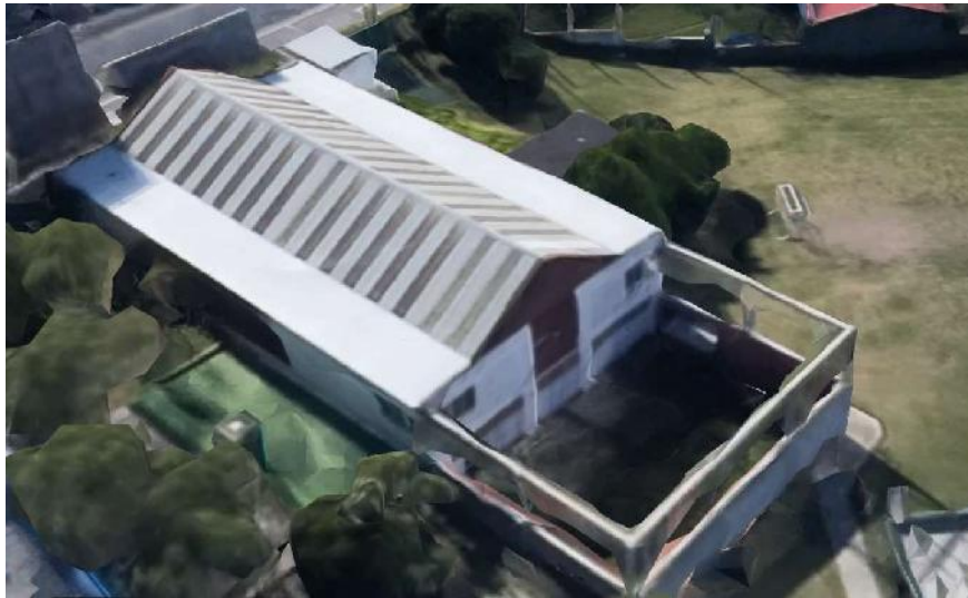
Figura 3.75 - Vista aérea de la superficie disponible para la instalación de equipos generadores
