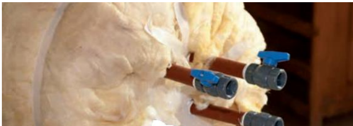
Figura 5. Base inferior del taque acumulador
