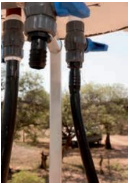
Figura 11 y 12. Llaves de paso, conectores y mangueras. Fuente: "Termotanque solar de agua. Construcción de tecnologías apropiadas". INTA Ediciones.
