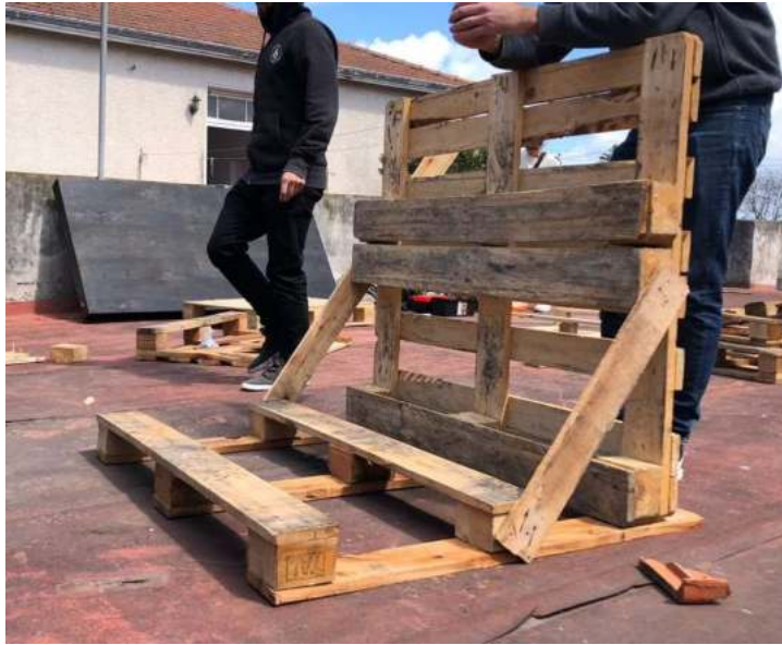
Figura 11: Palets a 90 grados, unidos por maderas sustraídas de los mismos Fuente: Elaboración propia.
