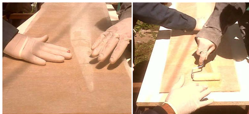
Figura 5.9 – Mat de 150 g/m 2 (izquierda), aplicación de la resina (derecha).
