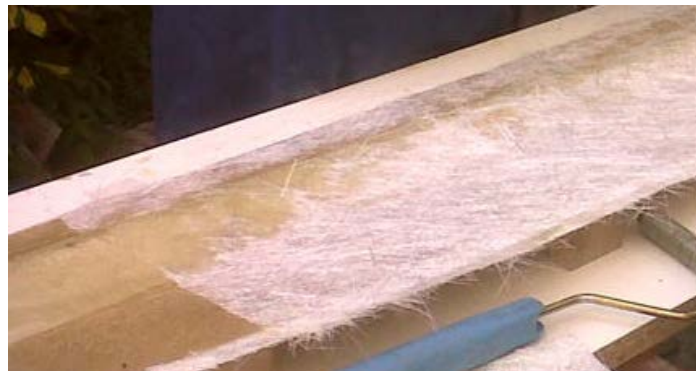
Figura 5.11 – Eliminación de burbujas de aire.
