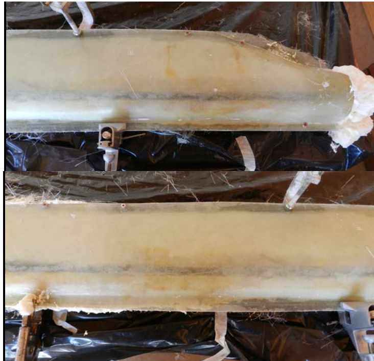
Figura 6.17 – Fijación de la viga.
