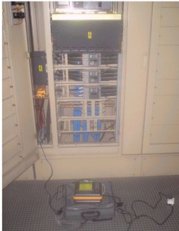
Figura 188-Ensayo con variador de velocidad (C.A.S).
