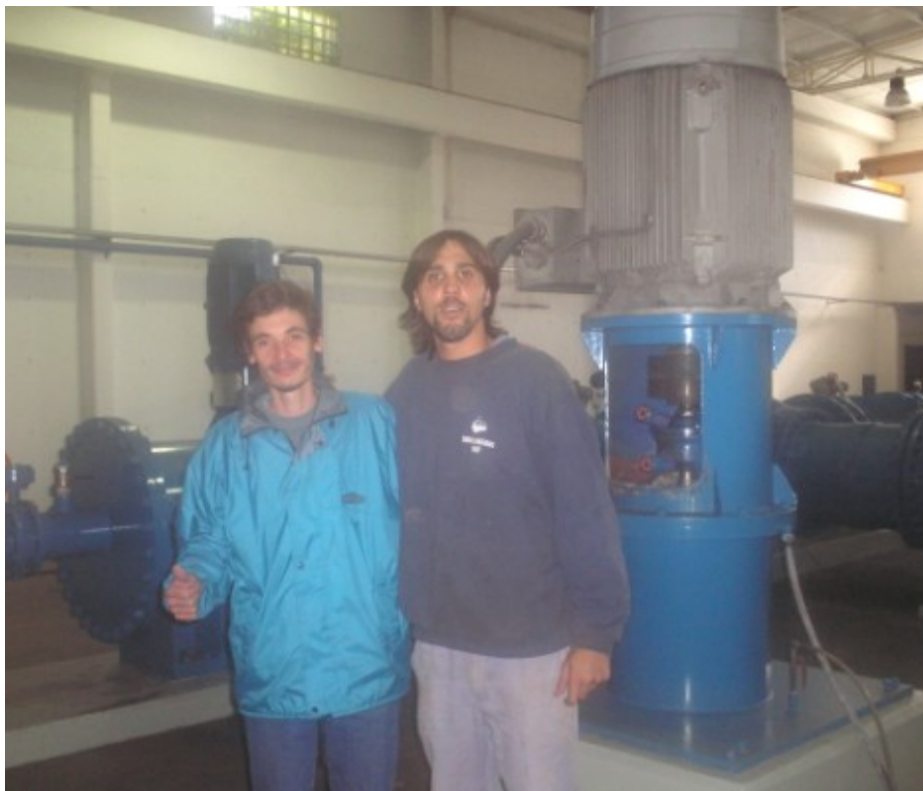
Figura 187-Ensayo con variador de velocidad (C.A.S).
