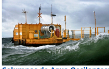
Columnas de Agua Oscilantes: Cámaras de aire donde las olas suben y bajan, accionando una turbina.
