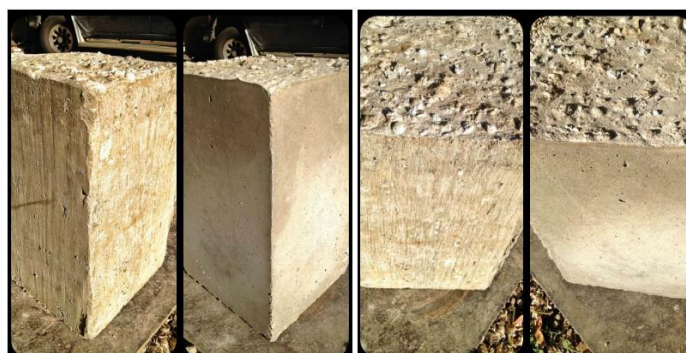
Figura 12: Terminación de encofrados de madera.
