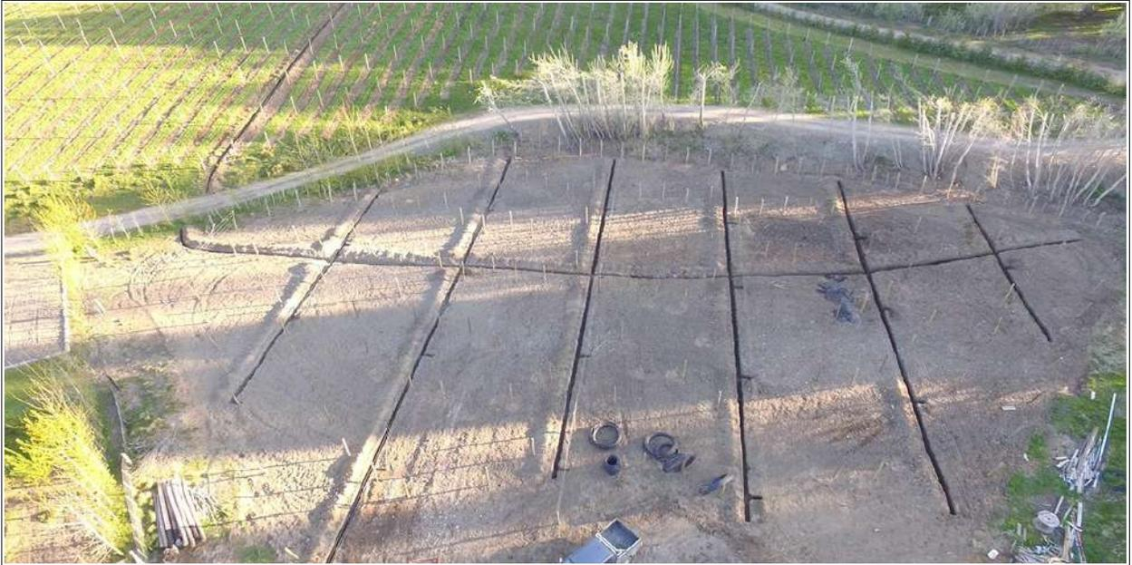
*Figura 11: Lote con el tendido de la red de distribución de agua.*
