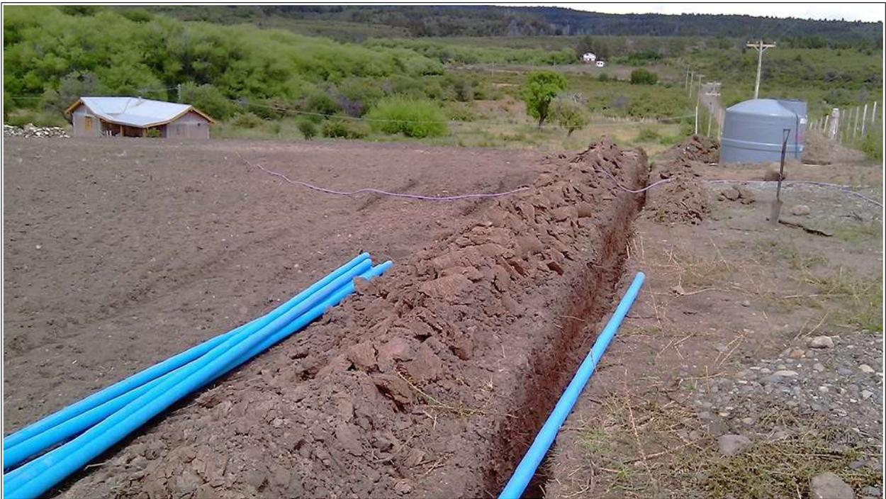
*Figura 10: Caños para la red de tuberías para transporte del agua.
