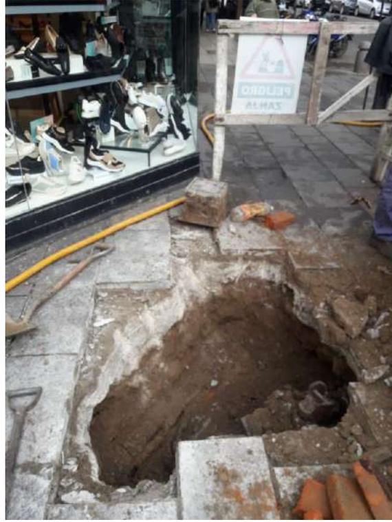
*Figura 4.1.5 Zanjeo para determinar la zona de la falla*
