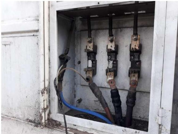
Figura 4.2.3 Conexión de los cables para realizar mediciones de reflectometría
