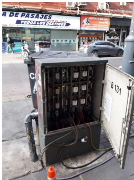
Figura 4.1.4 Conexión de buzón al cual se le realizaron las ondas de choque
