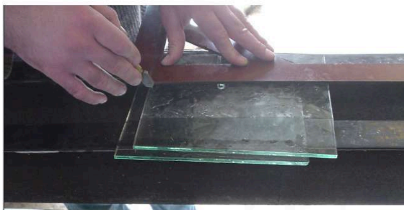
Marcado con el cortavidrios en el corte entrante de esquina tradicional
