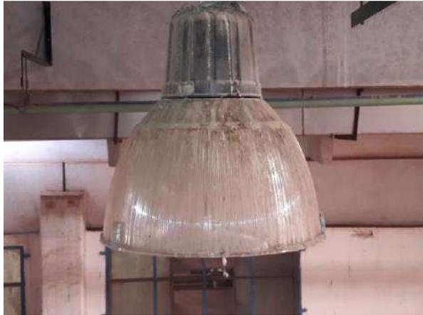
Foto 3.34 "Falta de mantenimiento en luminarias"-
