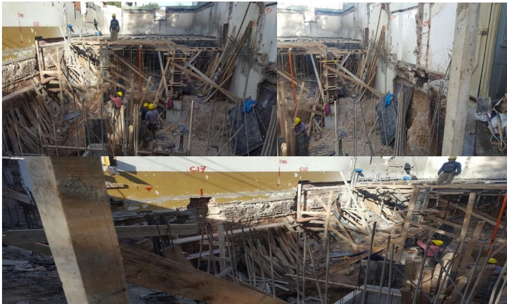
Foto 15 – Imágenes de la obra en ejecución. Submuración
