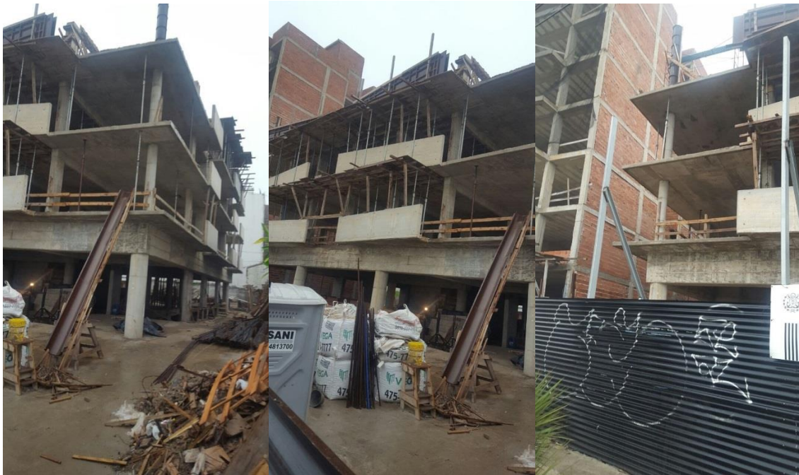
Foto 2 - Obra en Construcción – Av. De Los Trabajadores 3800 – Punta Mogotes
