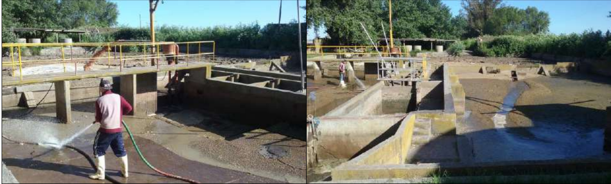
A – 6.3.4. Operario desempeñando tareas en la zona de filtrado.
