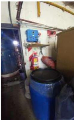
Figura 12 - Sustancias químicas ubicadas debajo de un tablero eléctrico
