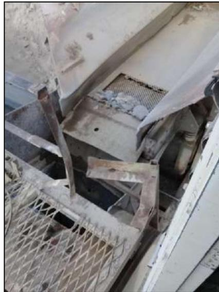
**IMAGEN 11 - Barandas en mal estado piso segundo nivel – Fuente propia**
