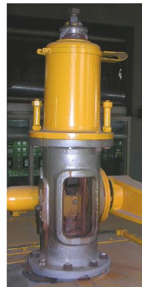
Figura 18. Válvula de regulación
