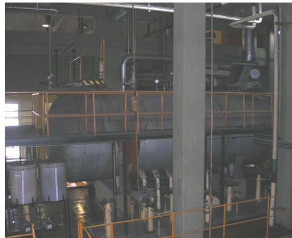
Figura 31. Desgasificador
