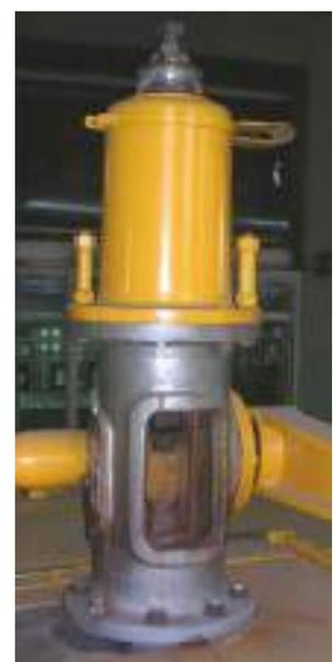
Figura 18. Válvula de regulación
