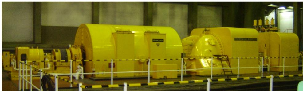
Figura 6. Turbina de vapor N° 8
