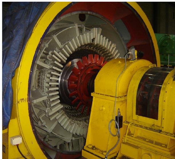
Figura 19. Interior del alternador
