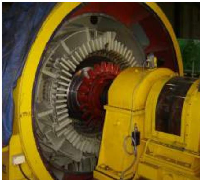
Figura 19. Interior del alternador
