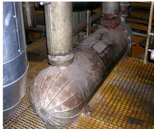
Figura 29. Condensador de vapor de sellos
