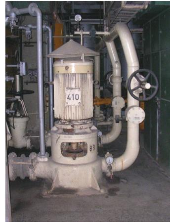
Figura 27. Bomba de extracción
