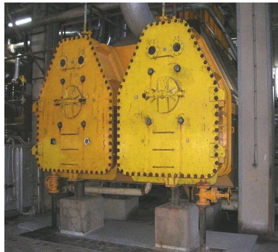
Figura 34. Condensador
