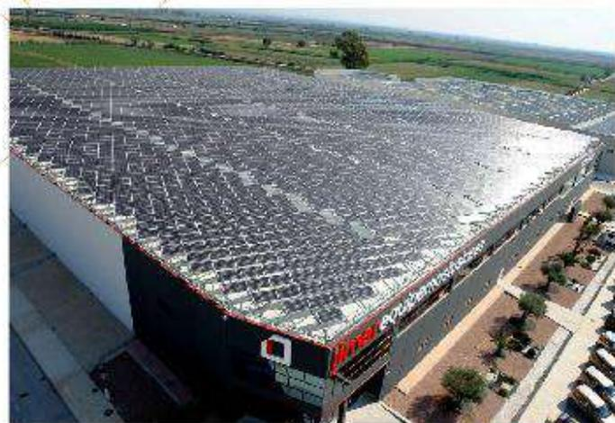
La estructura inclinada de Enersol, es la solución óptima para obtener la mayor producción en kWh, pues confiere al panel el ángulo de inclinación idóneo sobre la horizontal, ángulo que depende de la latitud del lugar.
