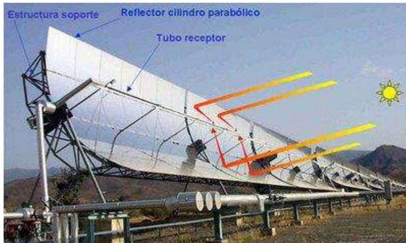
*Figura 4.2.2.2: Campo de concentradores con seguidor solar*
