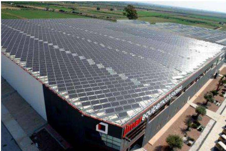
*Figura 5.8.4.1. Instalación realizada con estructura inclinada de Enersol.*
