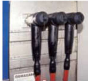
Conexión directa al embarrado
