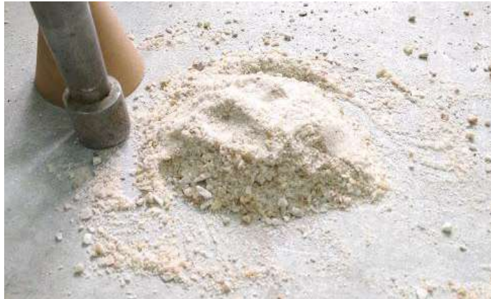
Figura 8. Proconcrete con menor humedad que SSS
