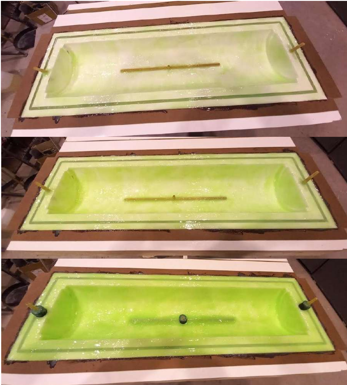
Figura 4.11. Resultado de la membrana luego de la aplicación de la primera, segunda y tercera capa (de arriba hacia abajo).
