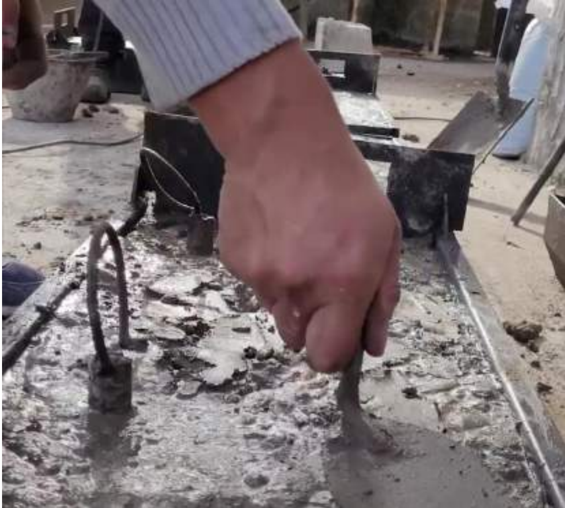
Figura 18. Llenado de molde con mezcla H13P10
