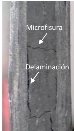
Figura 3.9. Presencia de delaminación entre dos microfisuras
