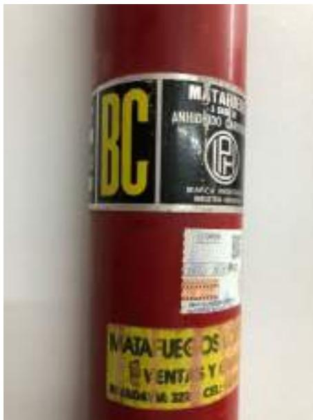
Ilustración 15: extintor a base de anhídrido carbónico BC. Fuente: propia.
