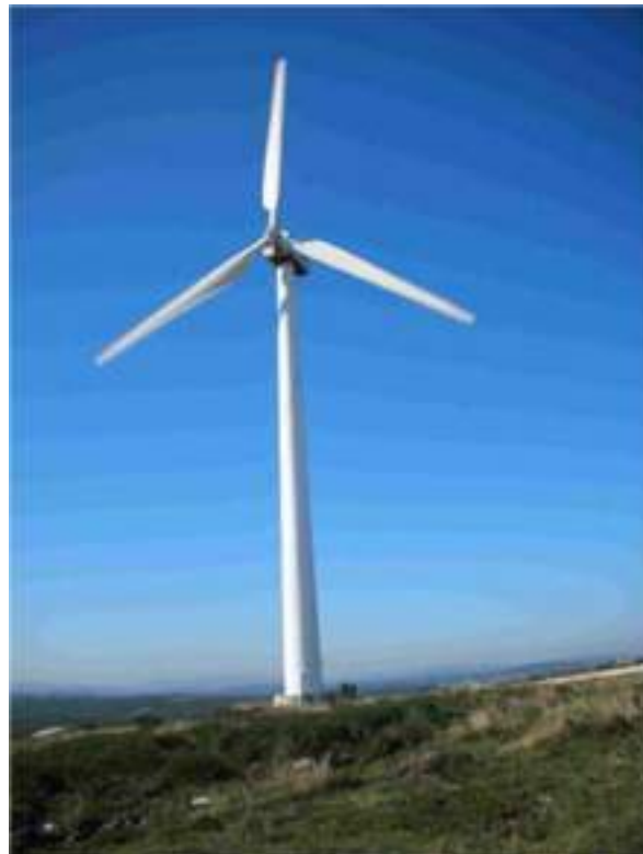
Figura 1.4.2. Aerogenerador eje horizontal.
