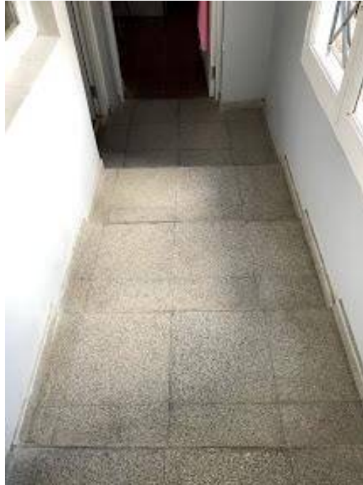
Figura 27: Escalones del pasillo de ingreso al “aula 4” y “aula 5”. Fuente: Elaboración propia
