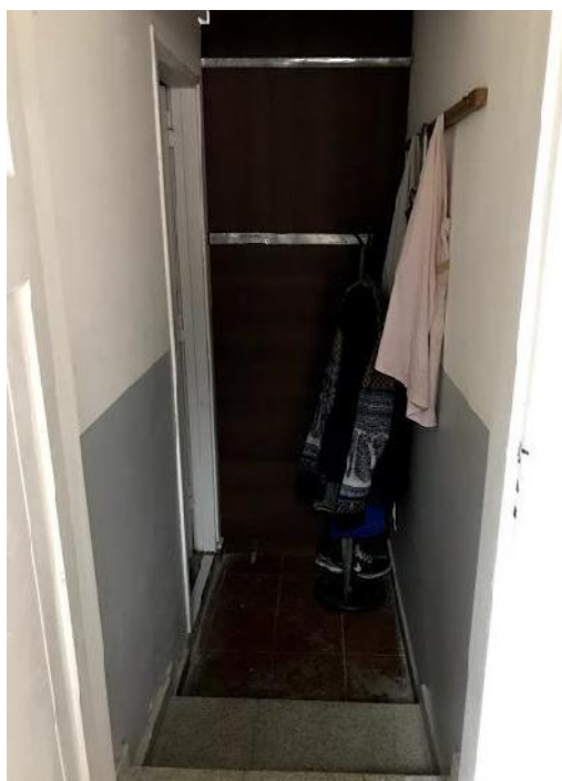
Figura 28: Pasillo de ingreso al “sanitario 3”.
