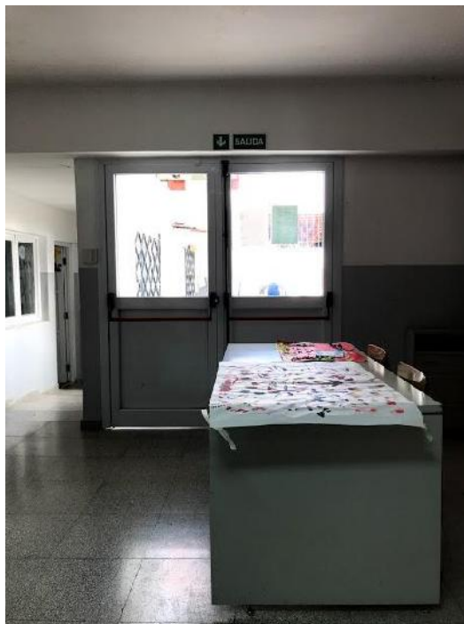
Figura 4: Salida de emergencia principal reducida en su ancho. Fuente: Elaboración propia
