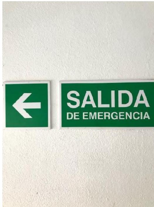
Figura 6: Señal de “Salida de emergencia”. Fuente: Elaboración propia
