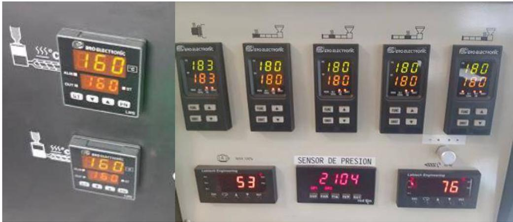
Figura 33. Temperaturas de tornillo utilizadas en la “Condición Suave”. Se observa arriba de cada temperatura la zona del equipo a la que corresponde esa temperatura.
