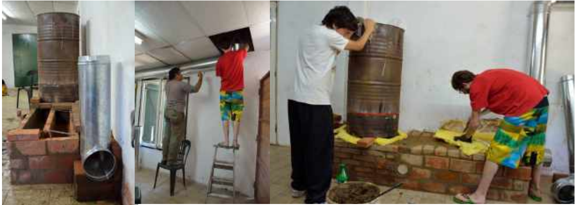
4. Construcción de banco de masa y colocación de tambor
