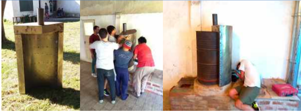
7. Instalacion de intercambiador de calor
