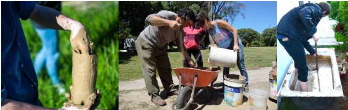
2. Preparación de la mezcla de barro.
