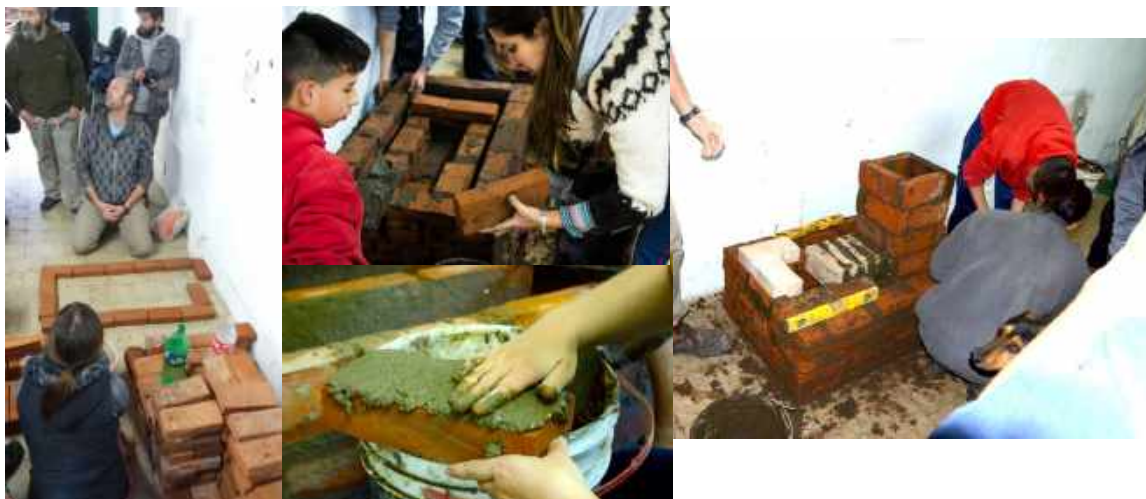
3. Construcción de primera etapa de estufa. Cámara de combustión y torreta
