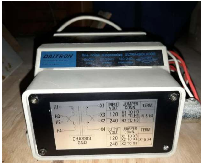
Figura 10.5- Transformador de aislación Daitron 500VA.
