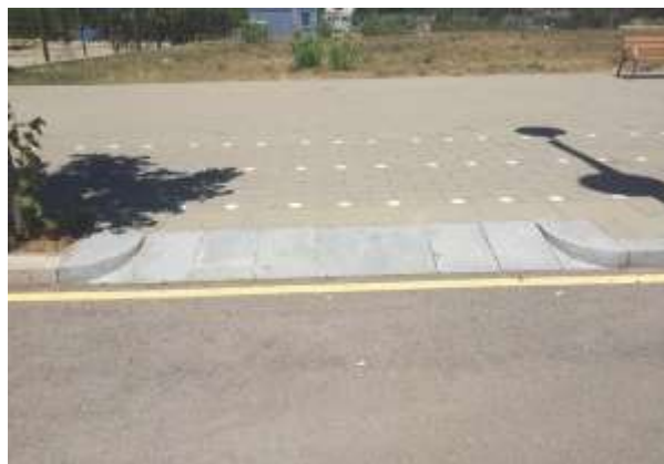
Figura 17: Vado rebajado. Fuente: Grupinex, 2019.
