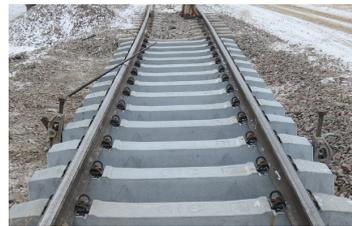
Figura 2: Durmiente de Hormigón
