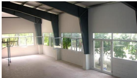
Figura 11: Columnas hechas con combinación de concreto y vigas de alma llena de sección variable.
