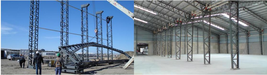
Figura 10: Columnas hechas con vigas reticuladas de sección constante y variable. Fuente: Solana SRL
