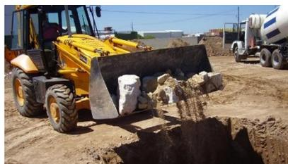
*Figura 4: Limpieza de terreno. Fuente: Solana SRL*
