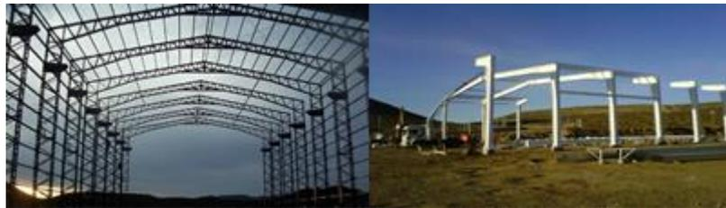
*Figura 6: Estructura hecha con vigas reticuladas y con alma llena soldada. Fuente: Solana SRL*
