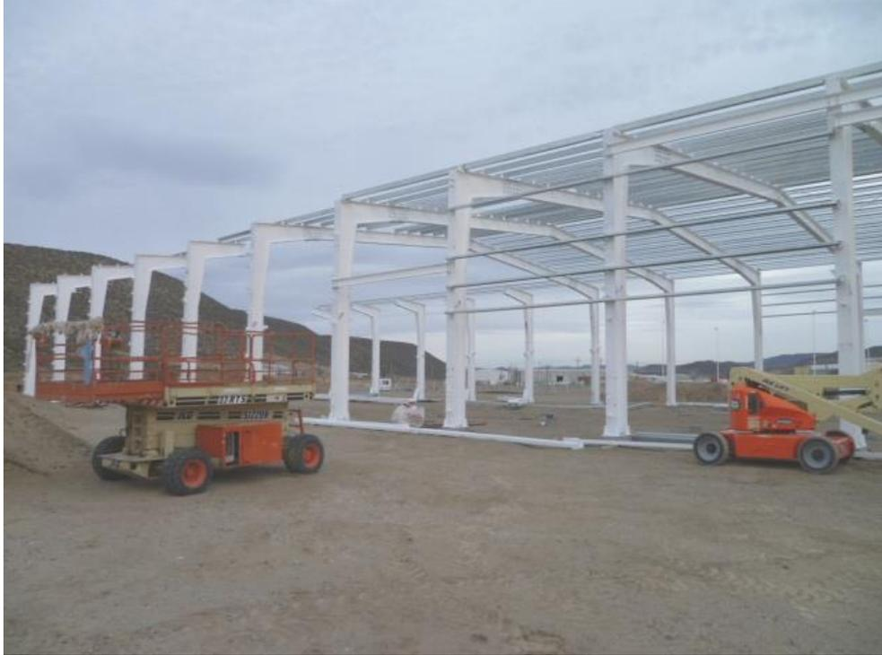
*Figura 31: Partes pintadas y colocadas. Fuente: Solana SRL*
