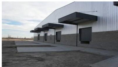
*Figura 7: Cerramiento hecho con chapas y bloques de hormigón. Fuente: Solana SRL*
