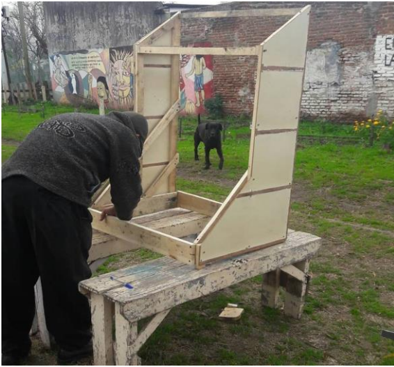
Figura 9: Construcción inicial y esperada de Deshidratador Solar.
