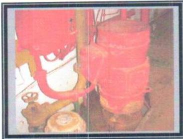
Para brindar el servicio de líneas de incendio a los barcos en dique, se acoplan las mangueras en las bocas de incendio y de ésta manera se derivan hacia los mismos.
