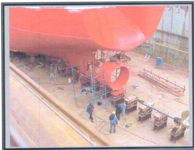
En la foto se puede ver el dique ya en seco y el barco ubicado en su posición. En éste caso en particular se está realizando la reparación de la línea de eje, que como se ve, se encuentra desmontada.
