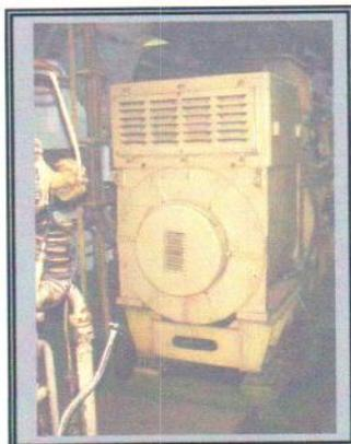
Moto-generador diesel de 200 Kw. vista desde el generador eléctrico.
