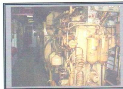
Moto-generador diesel de 200 Kw. vista desde el motor diesel (6 cilindros en línea)
