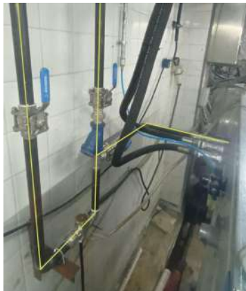
Figura N° 8: circuito de alimentación Lavadora 4. Fuente: elaboración propia
