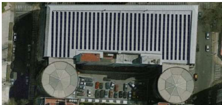
Figura 9: Paneles ubicados en orientación paisaje. Fuente: Plataforma Open Solar.
