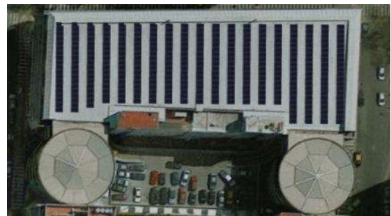
Figura 2 – Disposición de los paneles en el techo de la estación.
