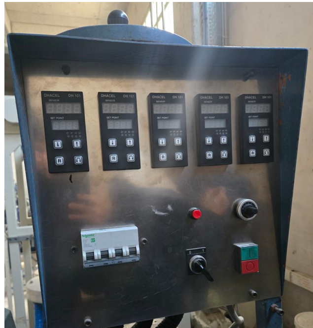
Figura 6-6: Control para extrusora recuperadora. Fuente: INTEMA.
