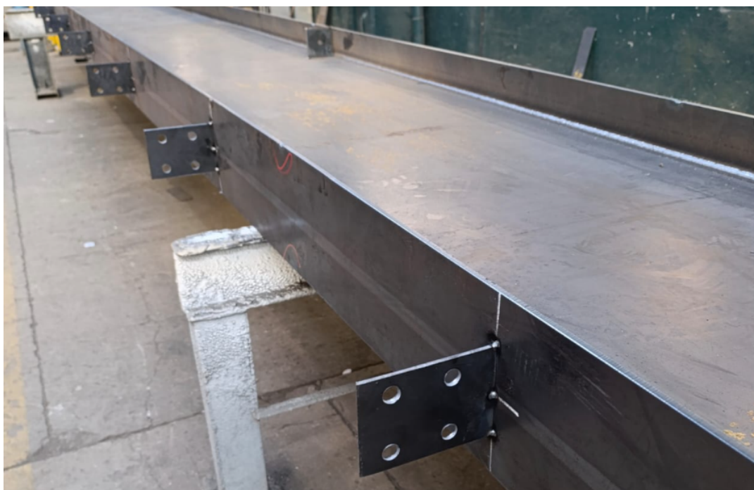
Figura N° 6: Colocación de piezas en el proceso de replanteo. Fuente: Imagen tomada en las visitas a la empresa.
